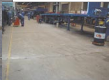
Fahrzeugwerke Faymonville AG, Bilingen/Belgium: Repairing expansion joints
