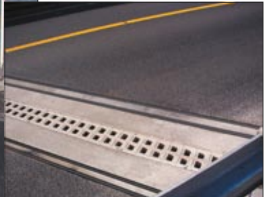
Autobahn A2 bei Hamm-Uentrop: Einbau der Entwässerungsquerrinnen
