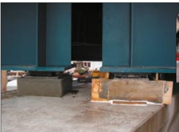
Eisenbahnbrücke Chemnitz-Einsiedel, Blankenauer Straße: Sanierung des Brückenwiderlagers
