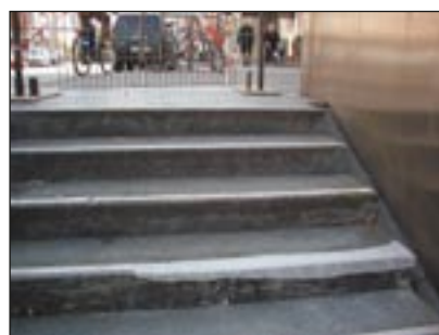
Treppe zur U-Bahnstation, Venloer-Straße, Köln: Sanierung der Stufen
