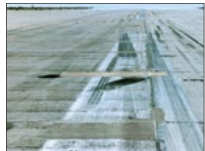
Flughafen Leipzig/Halle: Betonbahnsanierung auf Landebahn und Rollfeld
