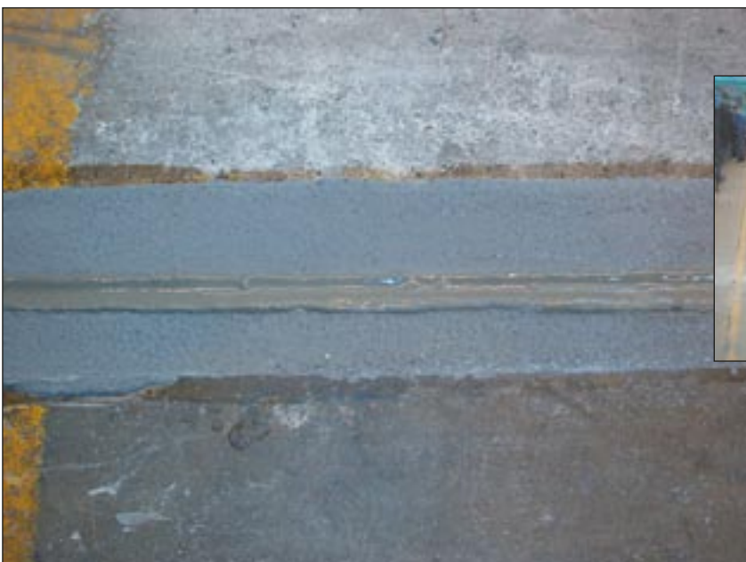
Fahrzeugwerke Faymonville AG, Billingen/Belgien: Sanierung von Dehnungsfugen
