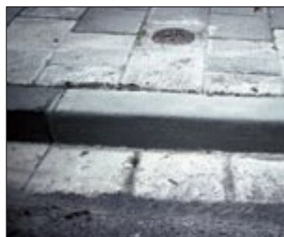
Sanierung von Bordsteinen mit SILIKAL® Mörtel R 17
