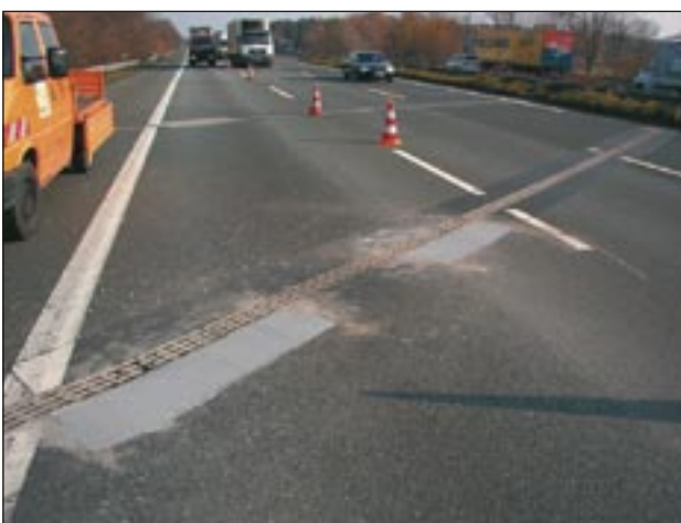
Autobahn A2 bei Bielefeld: Sanierung der Entwässerungsquerrinnen
