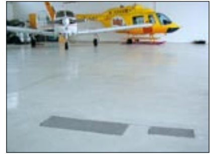
Flughafen Mannheim: Bodensanierung Flugzeughangar
