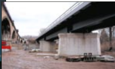
Neubau der Eisenbahnbrücke Chemnitz: Verguss von Brückenlagern im Winter
