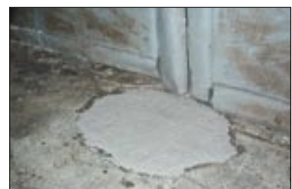
Bild oben: Deutsche See GmbH & Co. KG, Bremerhaven: Ausbesserung der Bodenflächen im Tiefkühlhaus bei laufendem Betrieb mit SILIKAL® Mörtel R 17 (-25 °C)
