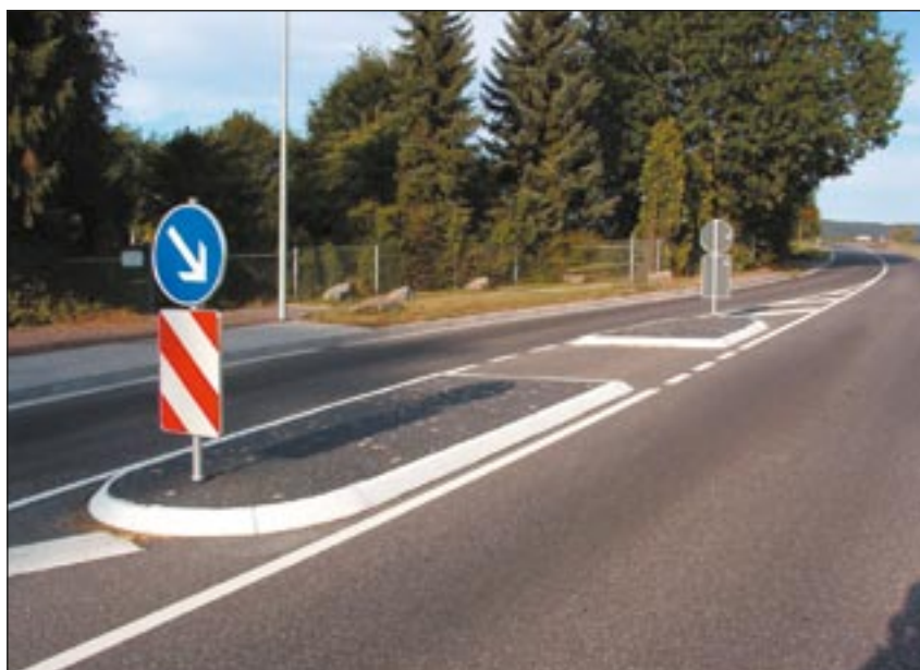
Kreisstraße K 106, Neuwied-Niederbieber: Mit SILIKAL® Mörtel R 17 auf Asphalt geklebte Flachborde für eine Fußgängerüberquerung
