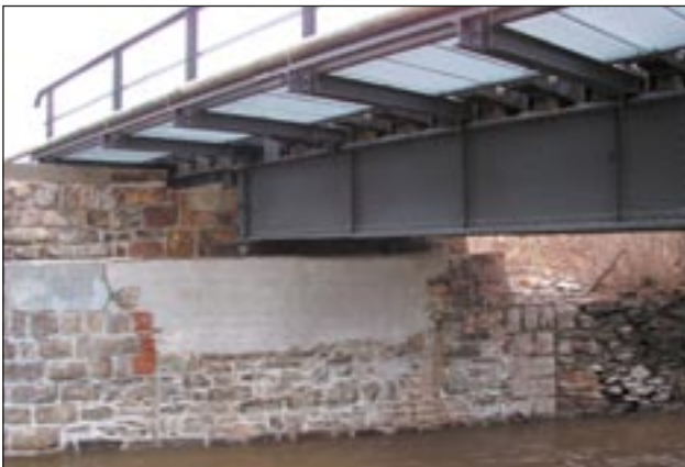
Eisenbahnbrücke Chemnitz-Einsiedel, Blankenauer Straße: Sanierung des Brückenwiderlagers
