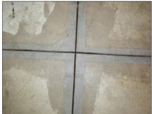
May Werke GmbH & Co. KG, Erfstadt-Köttingen: Sanierung von Dehnungsfugen
