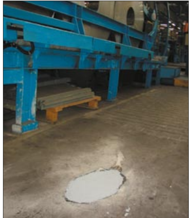
Bild oben: MHP Mannesmann Präzisionsrohr GmbH, Hamm: Sanierung von Bodenflächen
