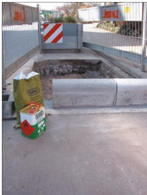
Ladenburg, Schriesheimer Straße: Herstellen einer Pflanzbeeteinfassung mit Bordsteinen, die mit SILIKAL® Mörtel R 17 auf Asphalt verklebt wurden
