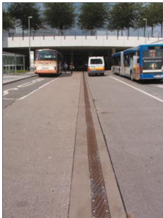
Busbahnhof Süd im Flughafen „Franz-Josef Strauß“ München: Sanierung der Entwässerungsrinnen
