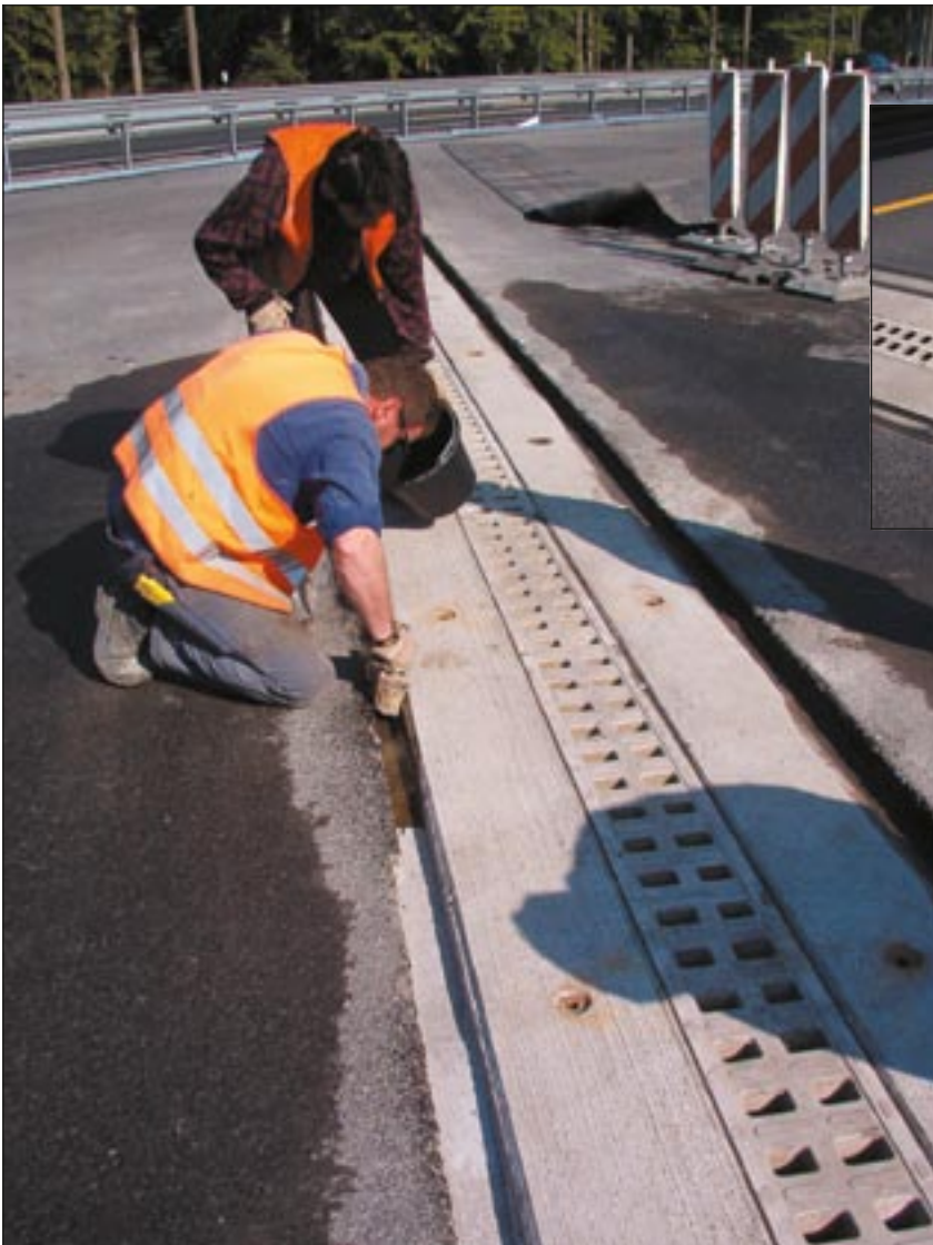
Autobahn A2 bei Hamm-Uentrop: Einbau der Entwässerungsquerrinnen
