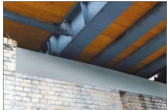
S-Bahnbrücke, Berlin, Sterndamm: Sanierung des Brückenwiderlagers
