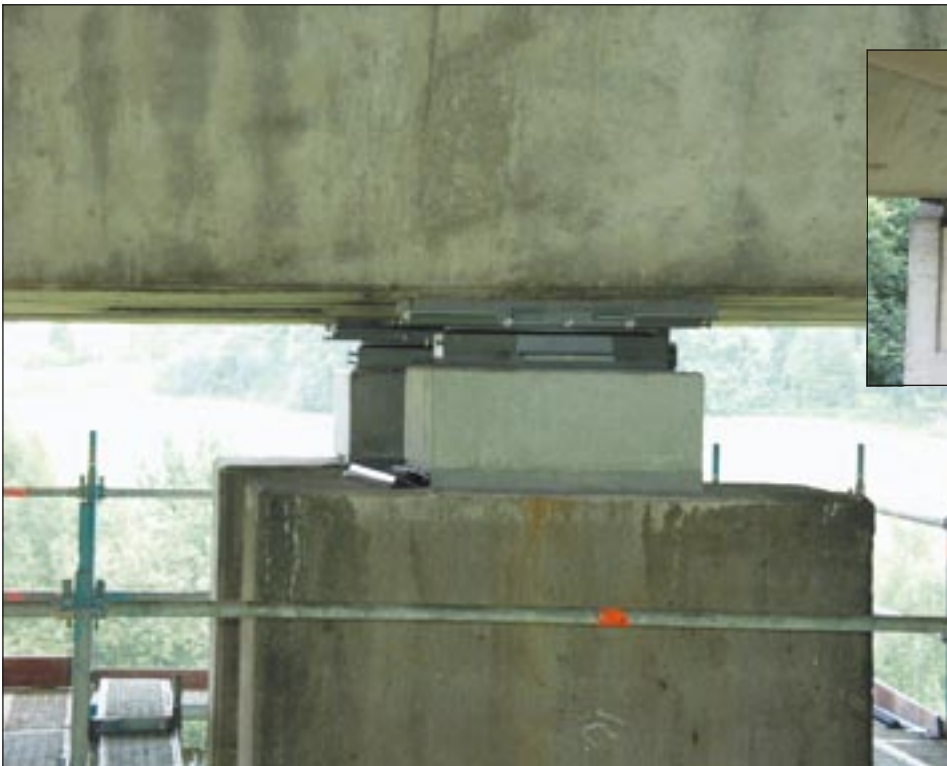
Autobahnbrücke A7, Uttrichshausen: Sanierung der Brücken- lager
