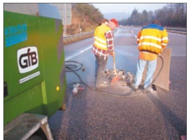
Autobahn A3 bei Neustadt/Wied: Ausbesserung der Fahrbahndecke
