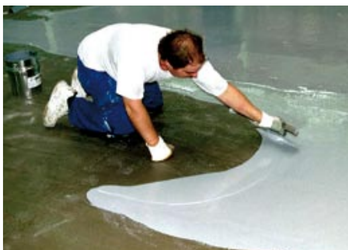
Application d'un revêtement épais
